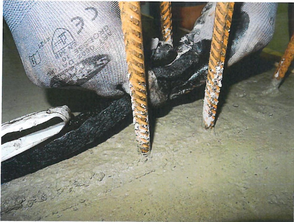
Bild 3 Überlappung im Eckbereich zusammendrücken
