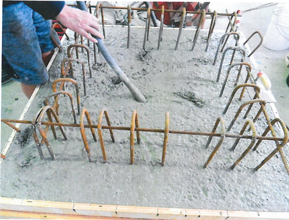
Bild 1 Betonage der Bodenplatte
