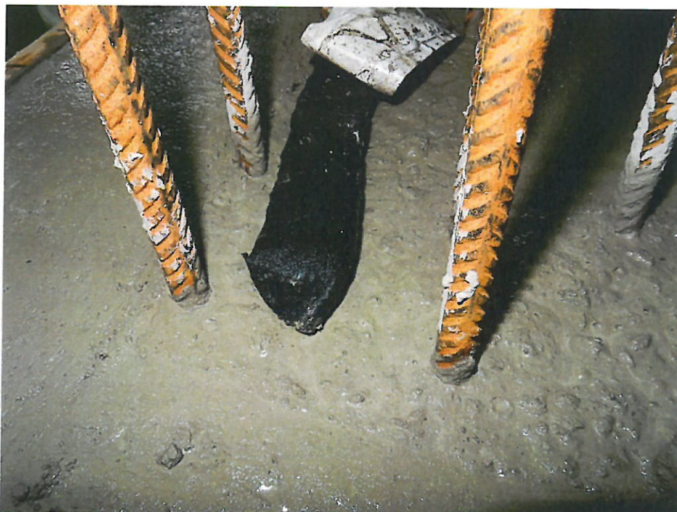
Bild 2 Verlegung des SynkoElast Abdichtungsband auf dem frischen Beton
